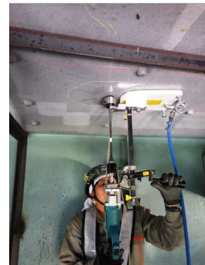
削孔状況 (床版下面から)
