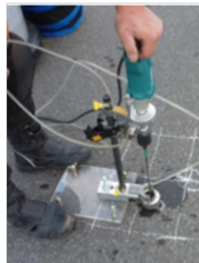
削孔状況 (舗装表面から)
