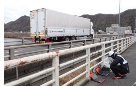
リアルタイムデータ計測状況
