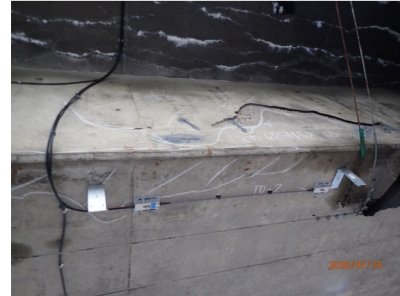
光学ストランドセンサ設置状況
