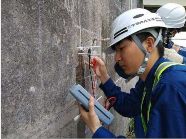
図1 接触法の測定状況
