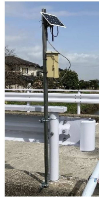
写真2 データ収集・通信装置設置状況
