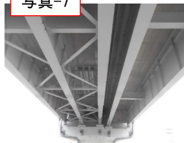
第1径間: 桁下(写真-7)
