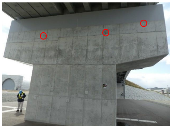
写真-3: P1橋脚 (終点側) (3パネル)
