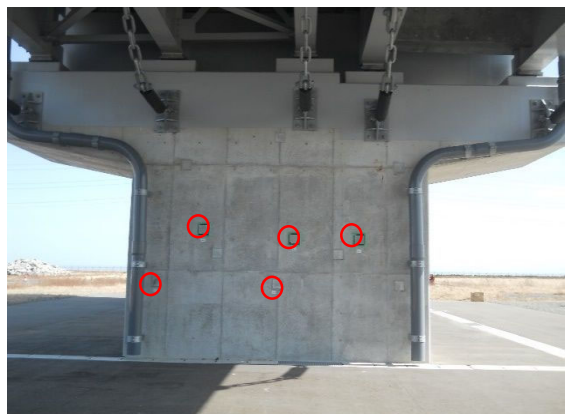
写真-2: P1橋脚 (起点側) (5パネル)
