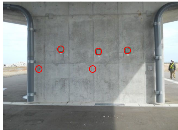
写真-2: P1橋脚 (起点側) (5パネル)
