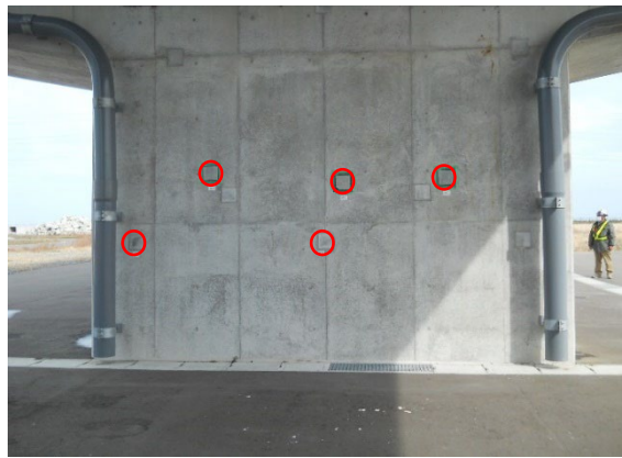
写真-2: P1橋脚 (起点側) (5パネル)
