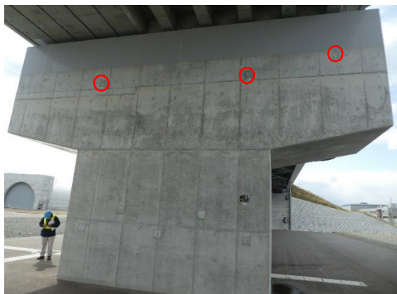
写真-3: P1橋脚 (終点側) (3パネル)
