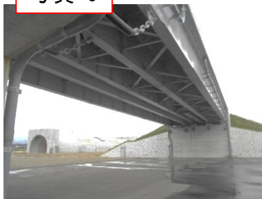
第1径間: 桁下(写真-6)
