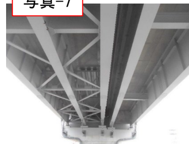
第1径間:桁下(写真-7)
