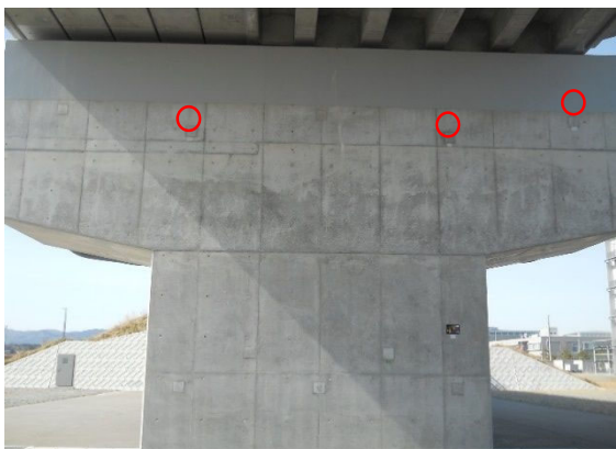
写真-3: P1橋脚 (終点側) (3パネル)
