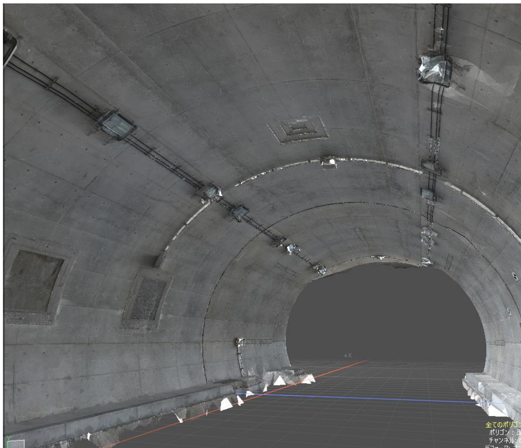
写真5 トンネル坑内三次元モデル画像
