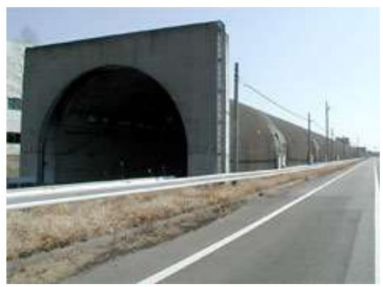
対象トンネル全体写真
