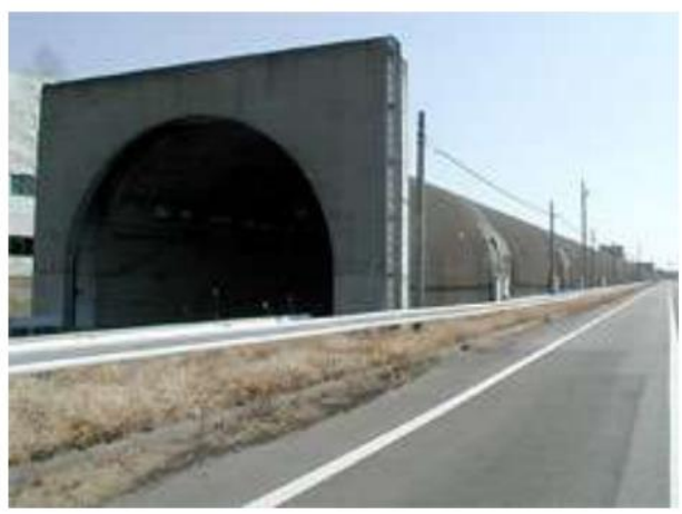
図2.トンネル全体写真
