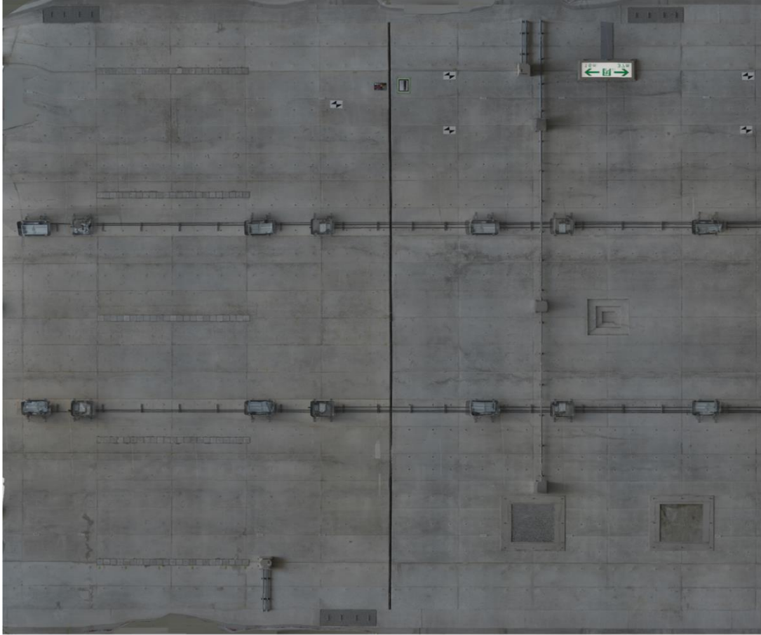
写真6.1 オルソモザイク画像（覆工アーチ部）
