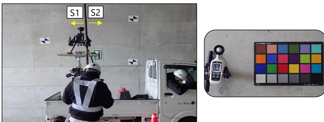
写真1 トンネルに設置したカラーチャートと計測状況
