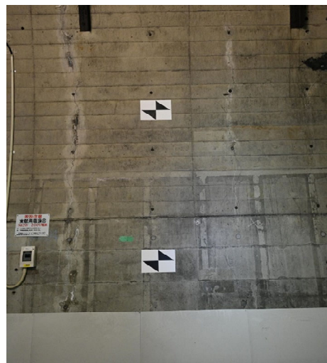
マーカー供試体 設置状況
