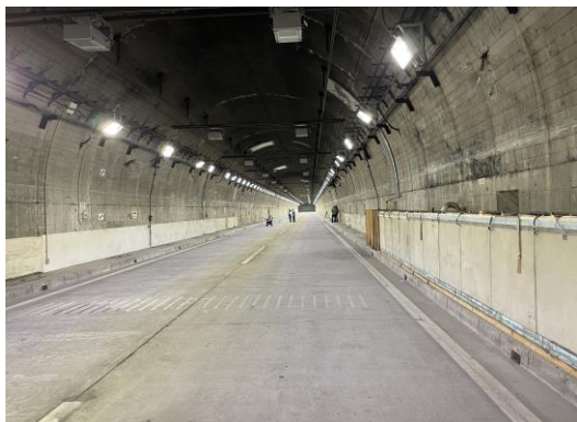
トンネル状況
