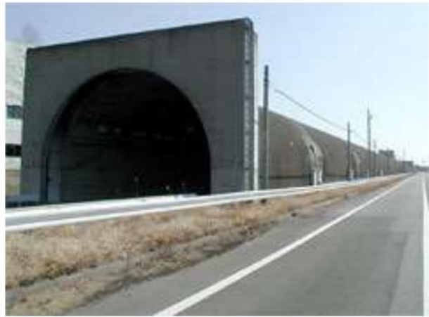
図2.トンネル全体写真
