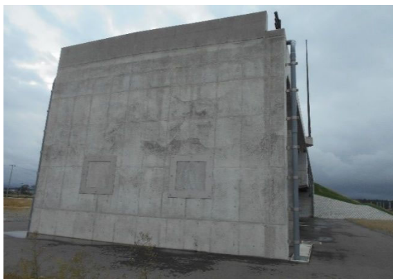
写真-1 A2橋台背面
