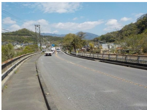
写真-8: 路面状況(起点より撮影)
