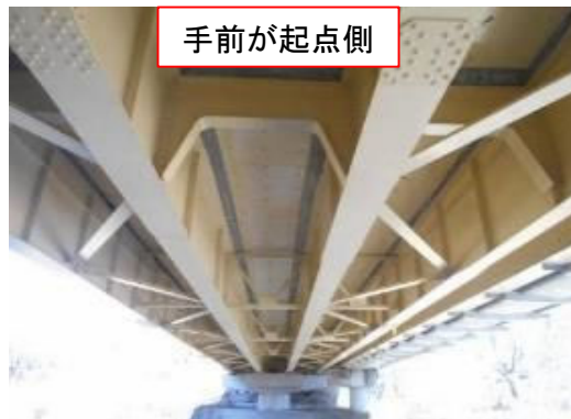
※床版は鋼板接着で補修されている。
