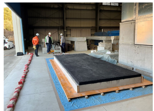
写真-2 検証試験体(床上)
