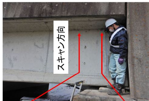
下り線歩道側
