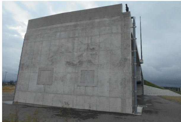
写真-1 A2橋台背面
