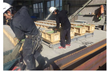
f) 後打ち打設
