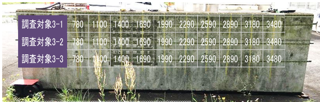
写真-5 計測箇所
