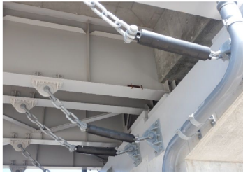
検 1 : ウェブ板平面による寸法計測 (ウェブからの離隔)
