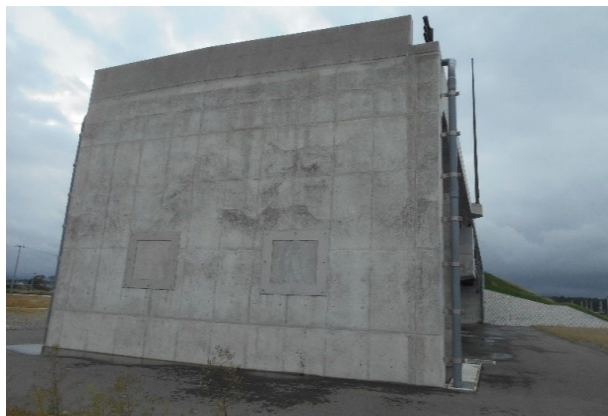
写真-1 A2橋台背面
