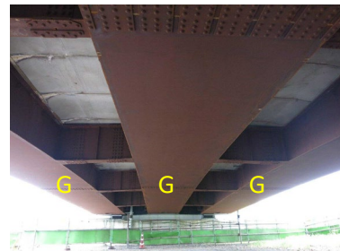
写真-2 3径間連続鋼箱桁橋
