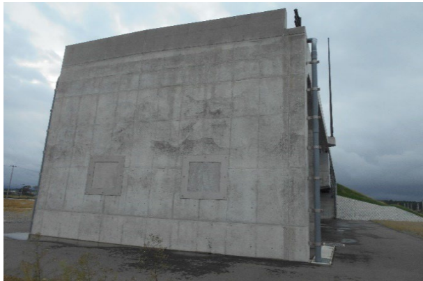
写真-1 A2橋台背面
