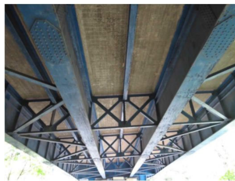
写真-2: 桁下(起点より撮影)
