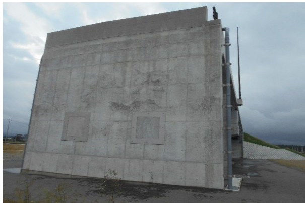
写真-1 A2橋台背面
