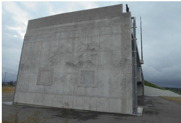
写真-1 A2橋台背面
