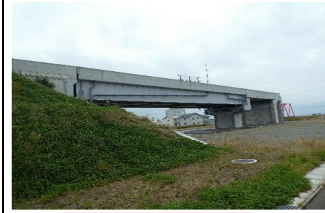
写真-1 全体写真
