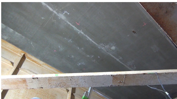
写真-1 床版状況 (現場試験実施箇所)
