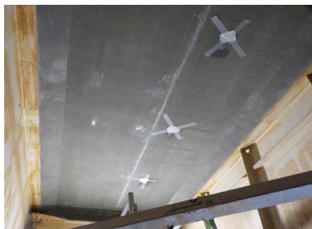
写真-1 床版状況 (現場試験実施箇所)
