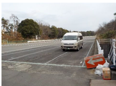
写真-8 路面上を車両で繰り返し走行させ、発生した弾性波を床版下面のAEセンサで検出
