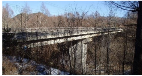
写真-1: 橋梁全景
