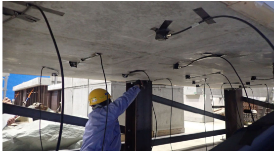
写真-6: センサとケーブル設置
