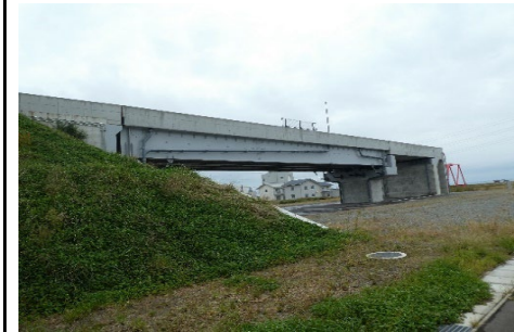
写真-1 全体写真
