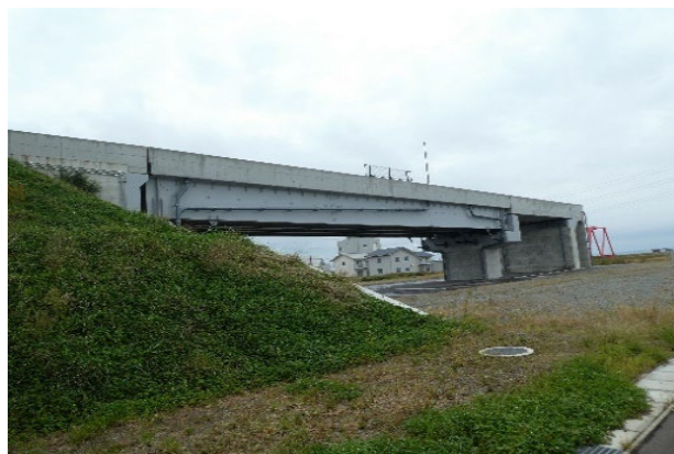
写真-1 全体写真
