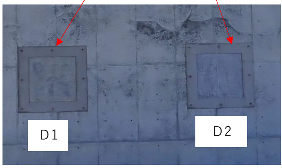
写真-2 検証試験体
