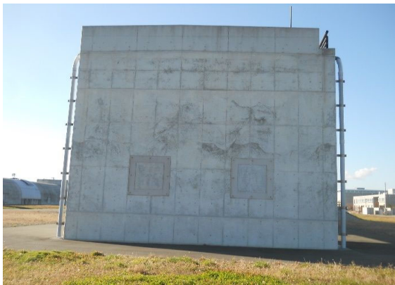
写真-1 A2橋台背面
