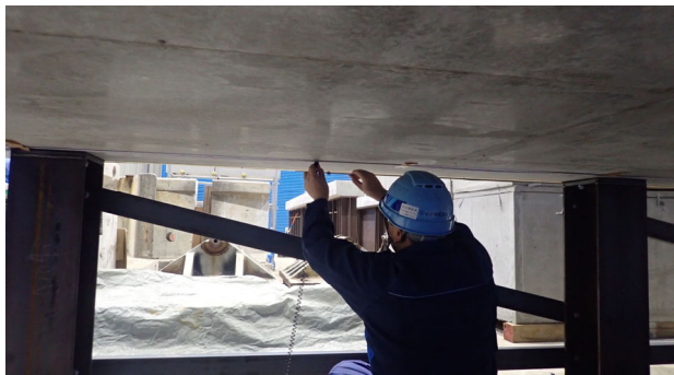
写真-7: 計測状況
