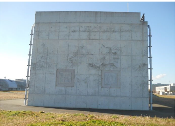
写真-1 A2橋台背面
