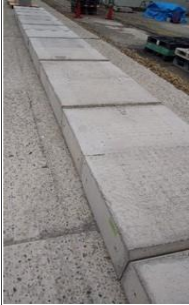
供試体 設置状況
