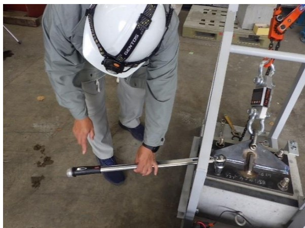
写真-4 ナットの締め付けトルクの調整
