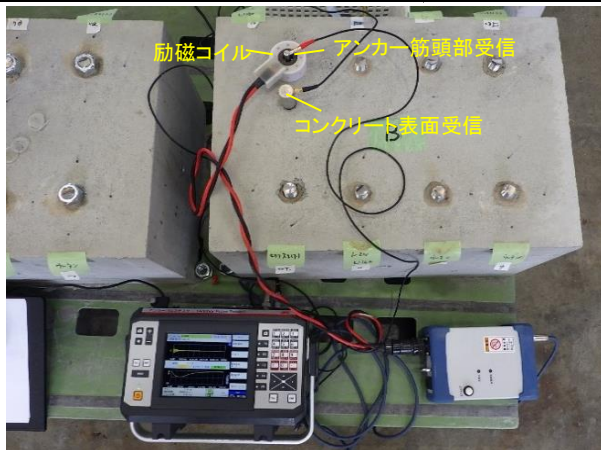
写真-3 電磁パルス法による定着部健全性評価の状況
