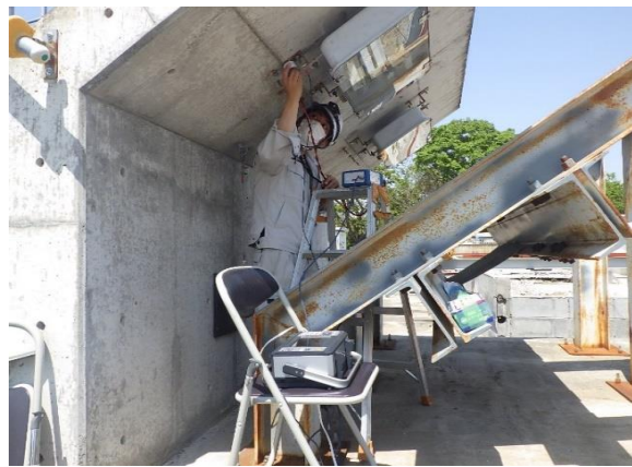
写真-2 電磁パルス法による照明灯具がたつき評価の状況
