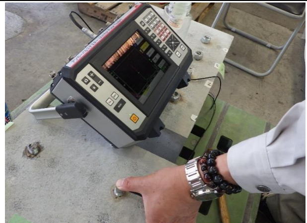
写真-4 超音波法によるアンカー長さ測定の様子
