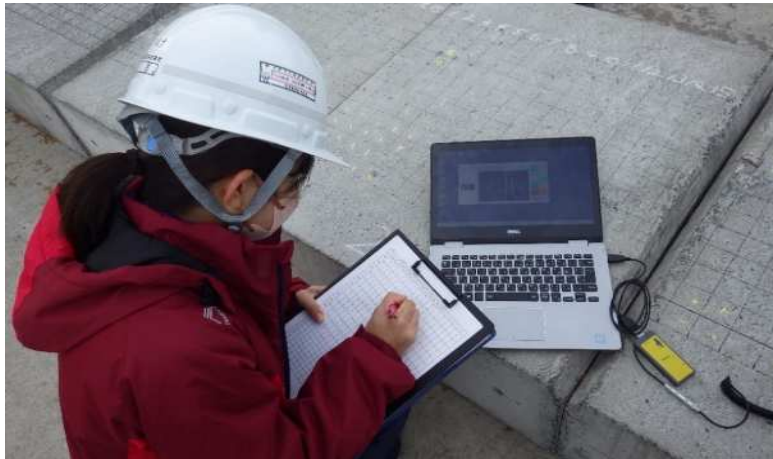
写真3. AI打音ハンマーの記録記入状況
