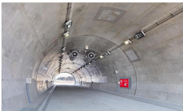
試験用トンネル内観
