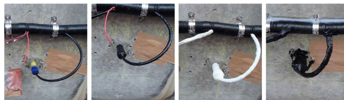
写真-4 鉛式照合電極の養生状況
