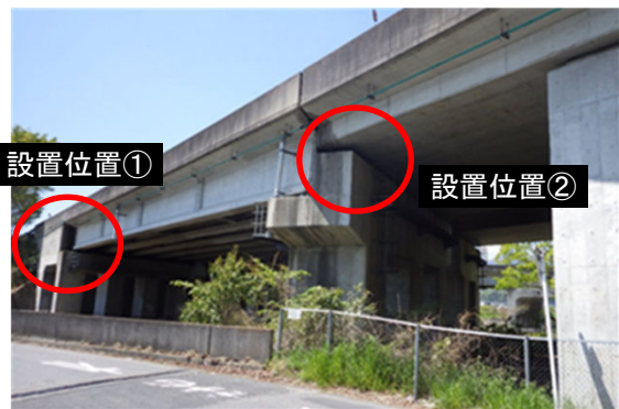
写真-1 M橋全景(PCI桁橋)
