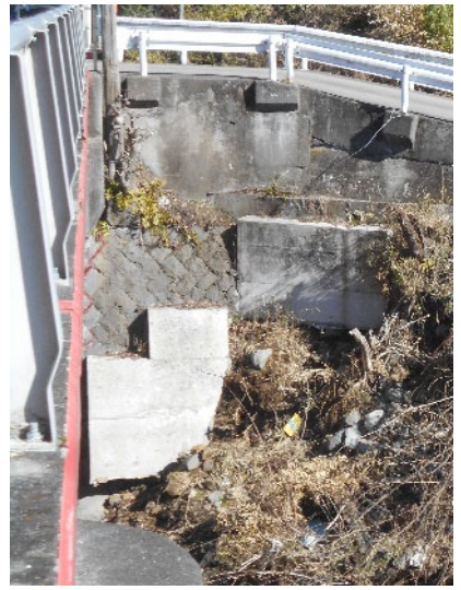
計測対象部材: A2橋台擁壁コンクリート
