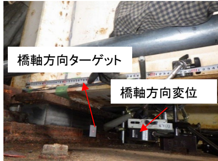
写真-5 橋軸方向変位計配置状況(G1)
