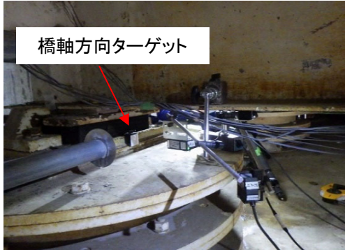
写真-5 橋軸方向変位計配置状況(G1)
