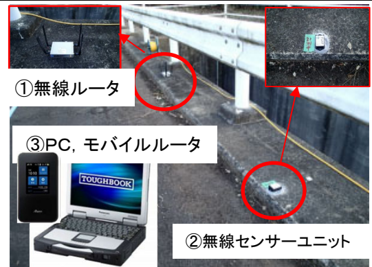
写真-3 機器の設置
