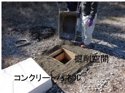
供試体① コンクリートパネル設置前
