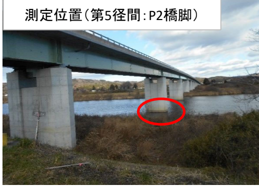
計測対象部材位:P2橋脚
