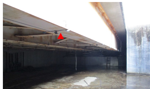
写真-2 測定対象桁及び測定位置
