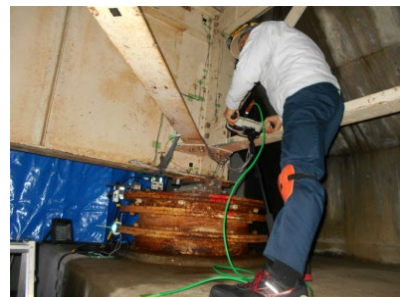
写真-4 計測状況
