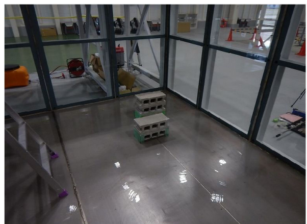
写真-2 小水槽内コンクリートブロック設置
