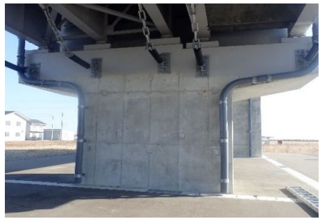
写真-2 P1橋脚
