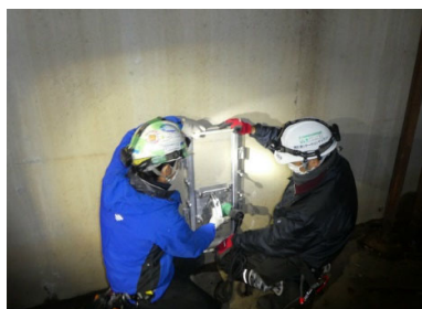
写真-5 カッター取り付け
