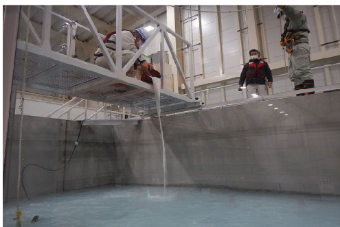
写真-12 濁度材投入
