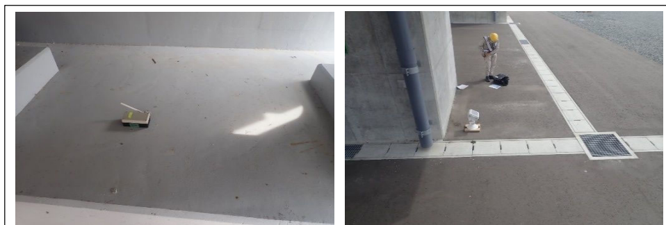
写真-5 設置(ゲートウェイを橋梁部以外に設置)
