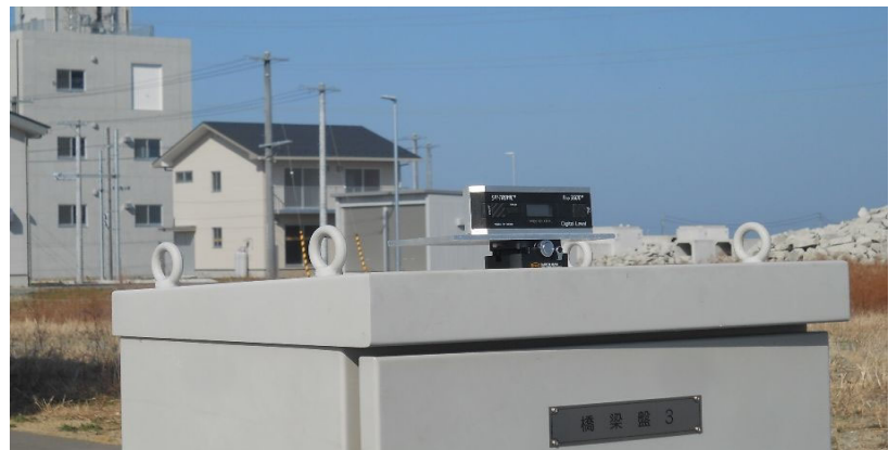
写真-4 傾斜架台+傾斜計
