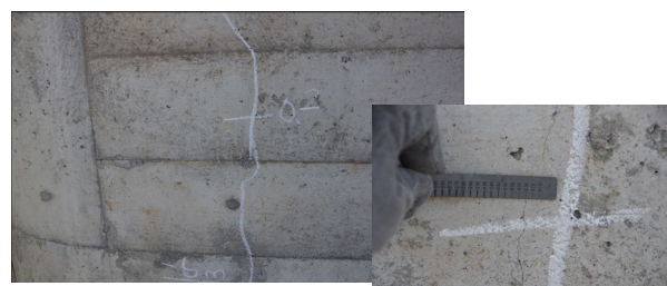
橋脚クラック直接計測 特殊高所技術点検
