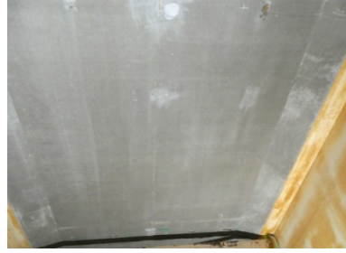
写真-2 床版状況
