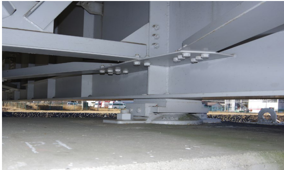
支承部撮影 支承部清掃・特殊高所技術点検撮影
