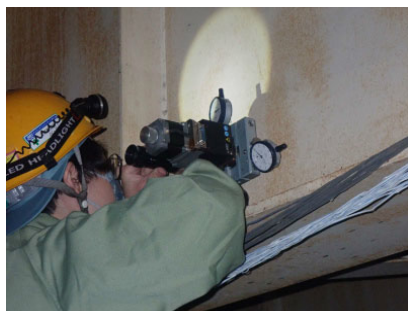
写真-3 主桁ウェブ測定
