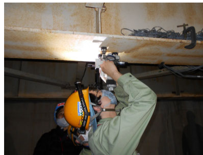
写真-4 主桁下フランジ測定
