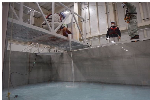
写真-10 濁度材投入状況
