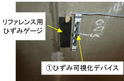
写真-4 機器の設置
