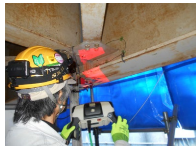
写真-4 計測状況
