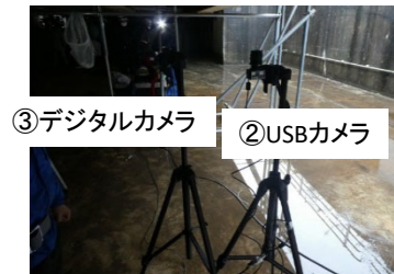
写真-4 カメラの設置
