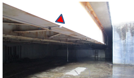
写真-2 測定対象桁およびひずみ測定位置
