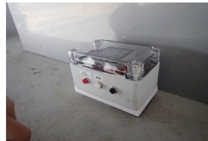
写真-5 計測装置設置
