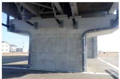
写真-2 P1橋脚
