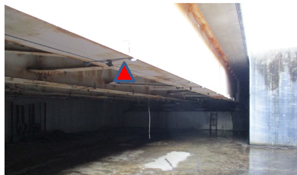
写真-2 測定対象桁及びたわみ測定位置
