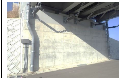
写真-2 A1橋台
