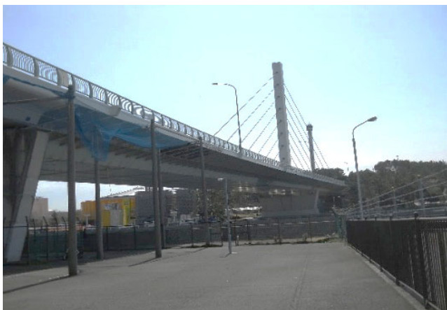
写真-1 柴航路橋 全景(起→終点方向)
