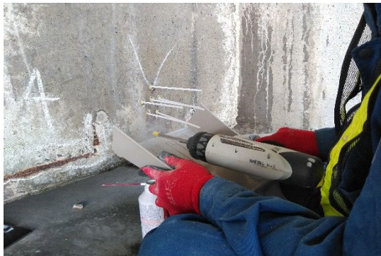
写真-1 ドリル削孔による試料採取
