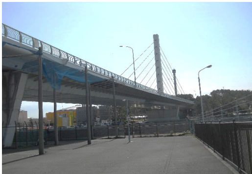
写真-1 柴航路橋 全景（起→終点方向）
