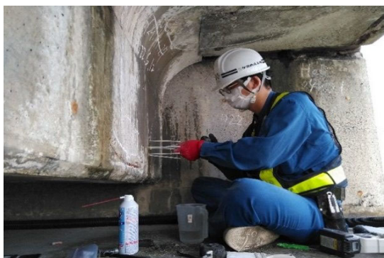
写真-3 削孔穴へスポンジ棒を挿入
