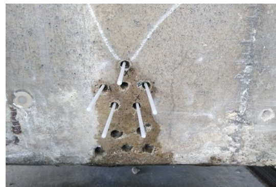
写真-4 削孔穴の湿潤養生状況
