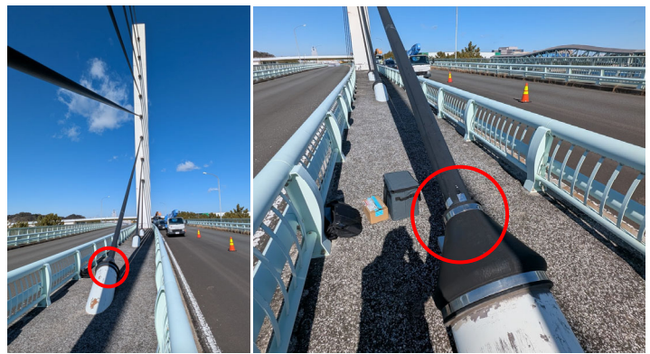
写真-2 測定箇所
