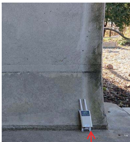
トンネル入り口に設置した4Gゲートウェイ
