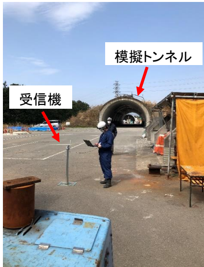
写真5a 通信試験状況
