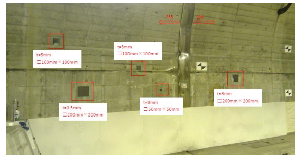
図5-2. 模擬うき設置状況
