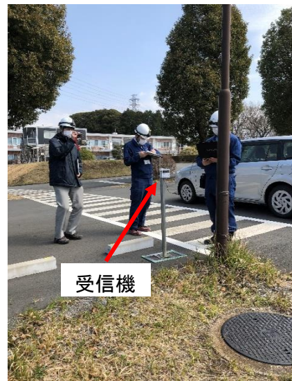
写真5b 通信試験状況 (185m地点)
