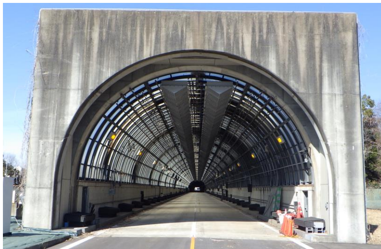
図1.トンネル坑口写真
