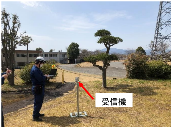
写真5c 通信試験状況 (340m地点)
