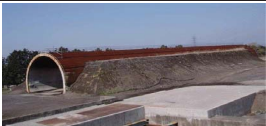
模擬トンネル全景
