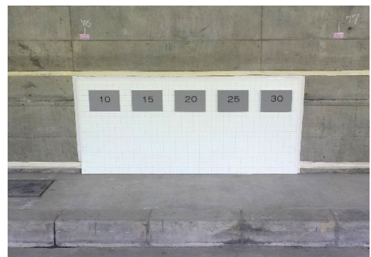
図4 模擬変状供試体 設置状況
