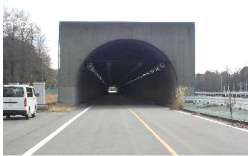
図1 対象トンネル(国総研実大トンネル)
