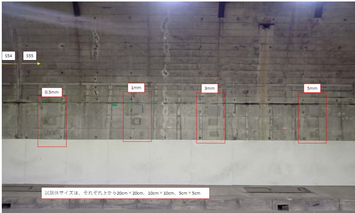
図1. 模擬うき 設置状況
