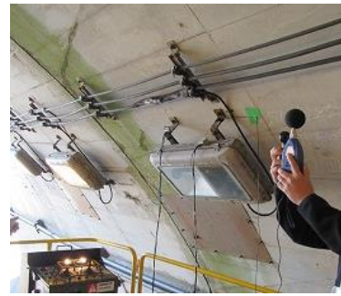
計測状況(Bトンネル)
