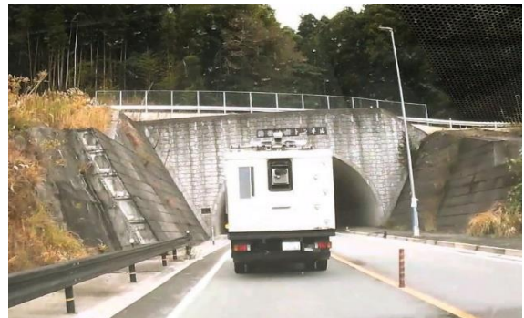
起点側坑口(北側) (下り線の計測状況※)
