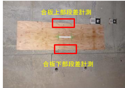
写真1 合板設置状況(合板厚12mm程度)
