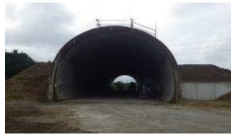
模擬トンネル全景(正面)
