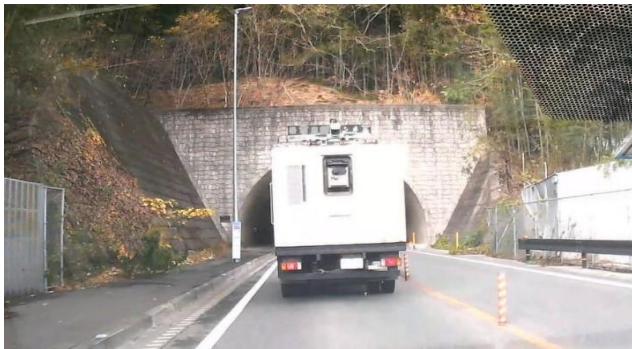
終点側坑口(南側) (上り線の計測状況)
