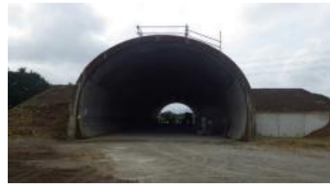
模擬トンネル全景(正面)
