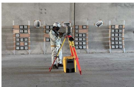
計測機器の設置、計測範囲等の設定
