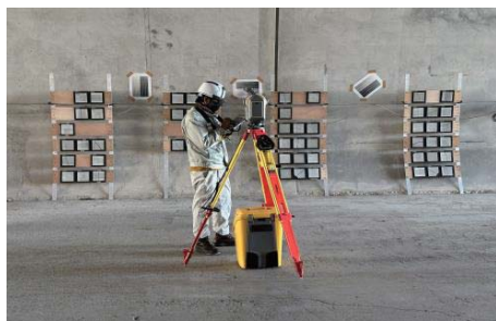
計測機器の設置、計測範囲等の設定
