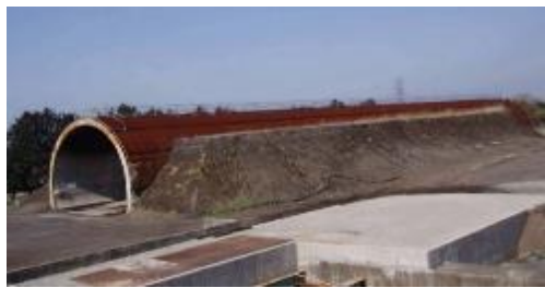
模擬トンネル全景
