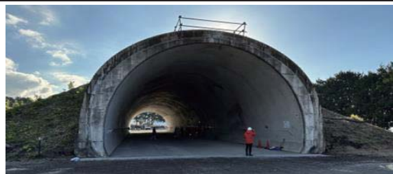
模擬トンネル全景(正面)
