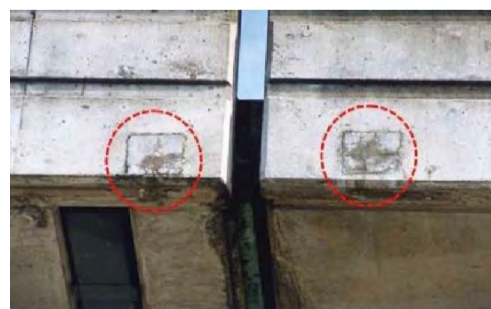
写真 2.4 ひび割れ、漏水（定着部）
