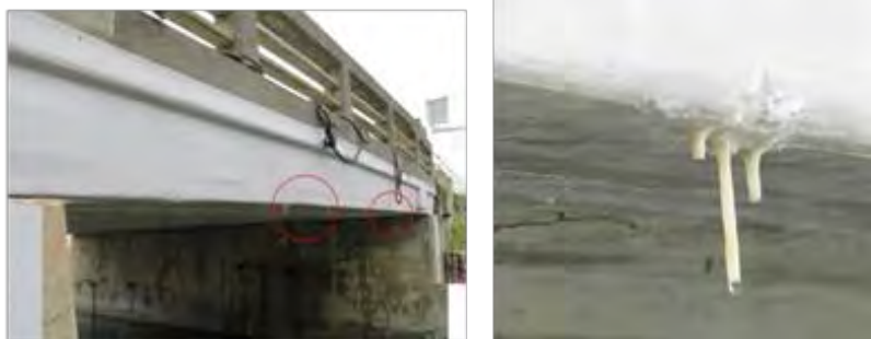
写真 2.6 補強材からの漏水の例
