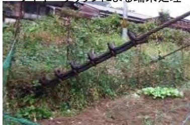
ワイヤークリップによる末端処理
