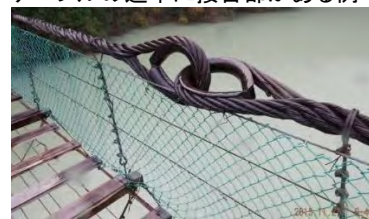
ケーブルの途中に接合部がある例
