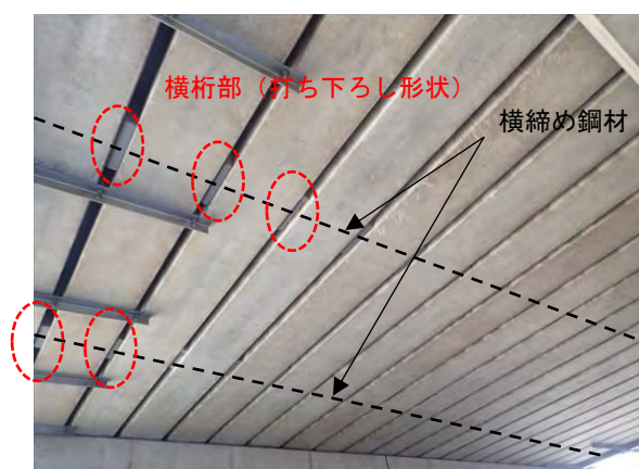
写真 2.1 横桁部の打ち下ろしの例
