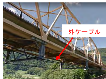
鋼橋の外ケーブル補強の例
