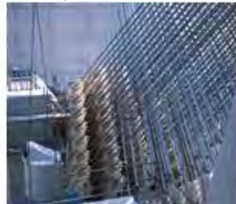
アンカーフレームに分散させて定着
