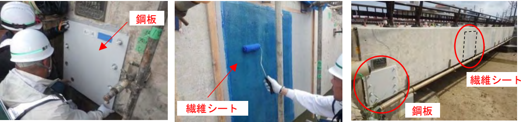
写真 2.3 横締め PC 鋼材の突出防止対策
