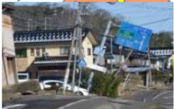
内灘町西荒屋地内 (液状化)
