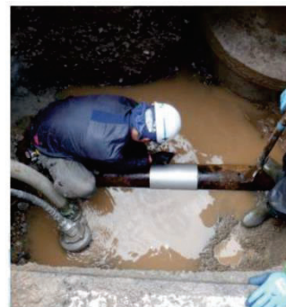
配水管漏水修理の様子
