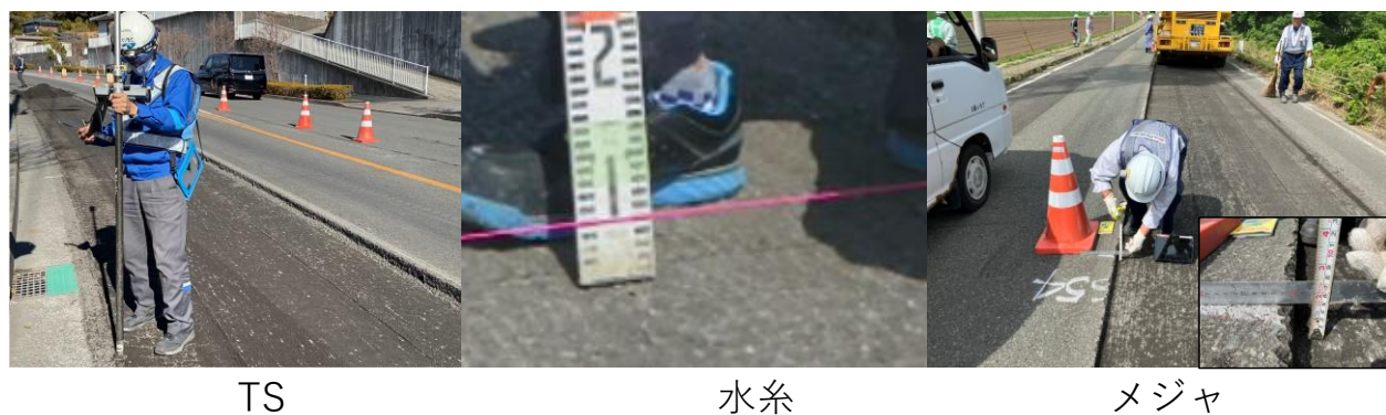
図3-3 高さまたは切削深さの計測実施例
