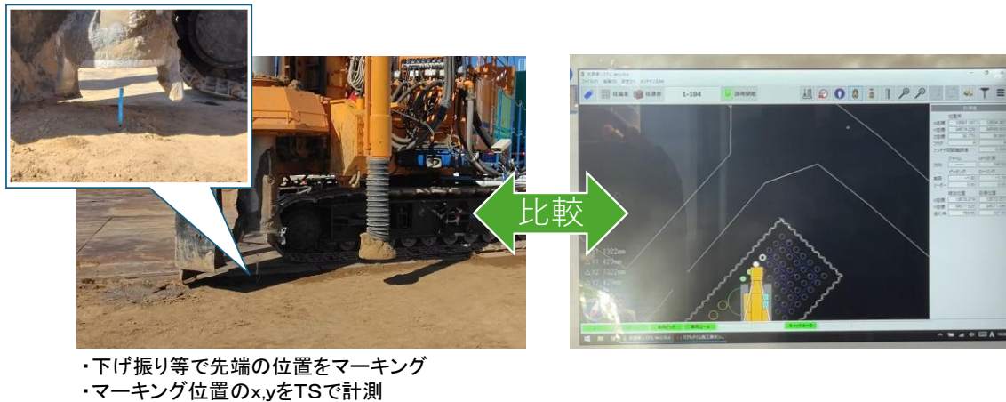
図7-4 位置計測精度の確認
