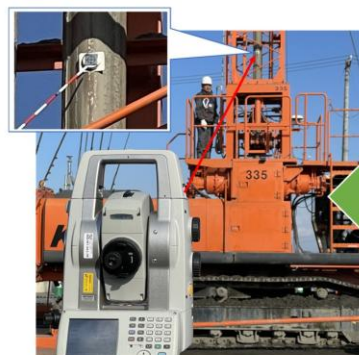
・ 高さ計測状況 (打設ロッドにマーキングした例)
