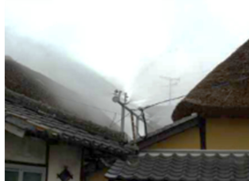
水膜の生成による延焼遅延効果
