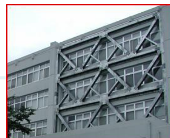
耐震改修 (例: 鉄骨による補強)
