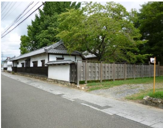
保存・修理後の長屋門(敷地南東側)
