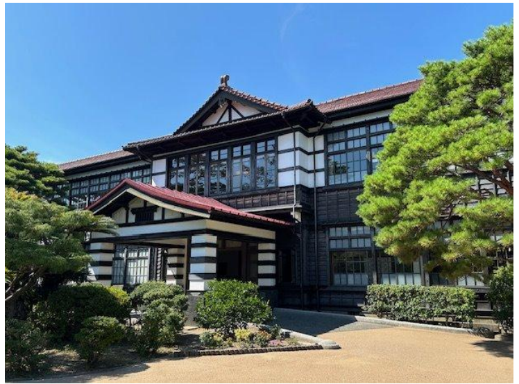
整備後の萩・明倫学舎のエントランス
