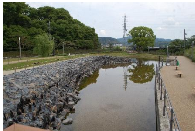
再現された石積み護岸
