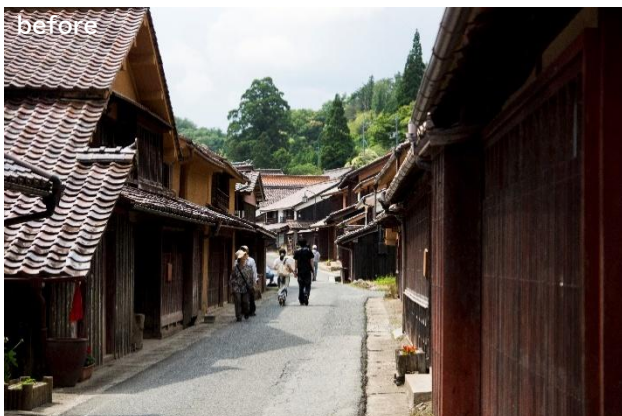
路面が傷んだ道路
