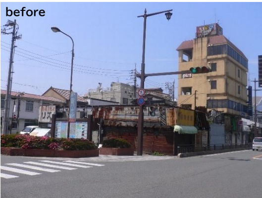
唐樋札場跡に建ち並んでいた老朽化した商業施設
