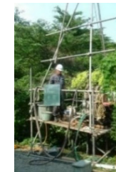
安全性把握調査 (ボーリング調査)
