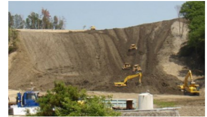
盛土撤去工事のイメージ
