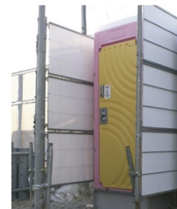
狭小地における設置の様子
